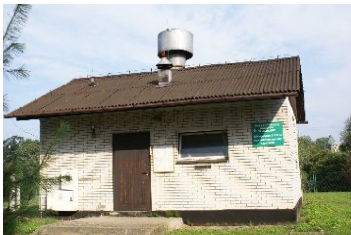
Oczyszczalnia ścieków w Jedlinie przy ul. Wolskiej
