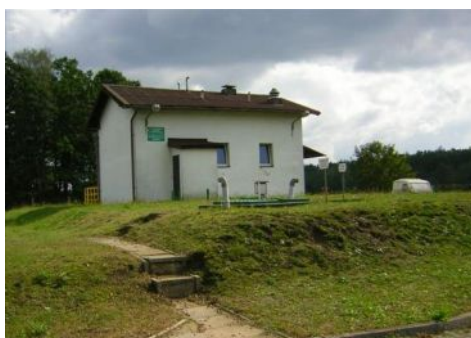
Biologiczna oczyszczalnia ścieków w Międzyrzeczu przy ul. Międzyrzecznej
