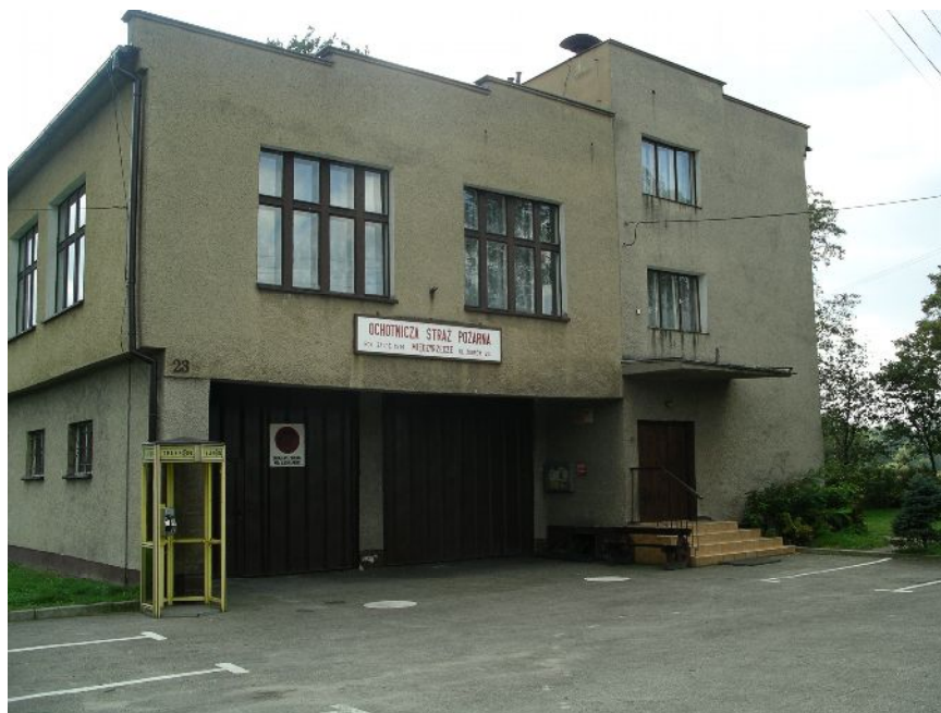
Budynek Ochotniczej Straży Pożarnej przy ul. Żubrów 23
